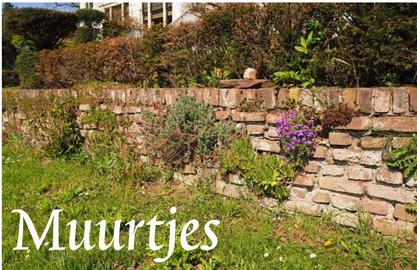
Gemetzelde muur met uitsparingen voor muurplanten, Huis Empe te Empe (Gld). Foto van Donkelaar Groenadvies.
